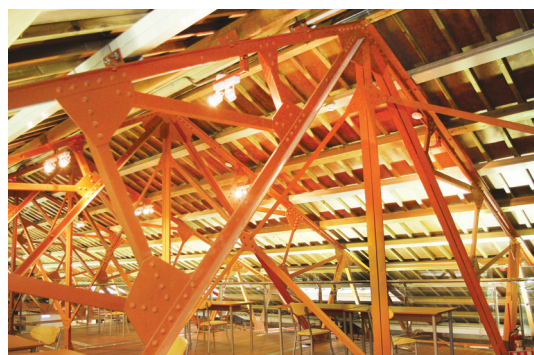
圖書館保留芬克式桁架及傳統三角屋面結構，創造了新的閣樓空間，也提供了教育參觀的價值。
