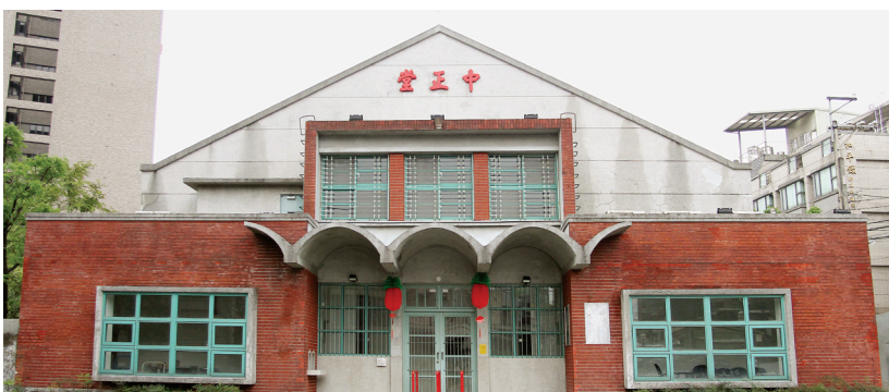
中正堂為三進三開間的建築格式，入口遮雨處則為三連拱樣式。
