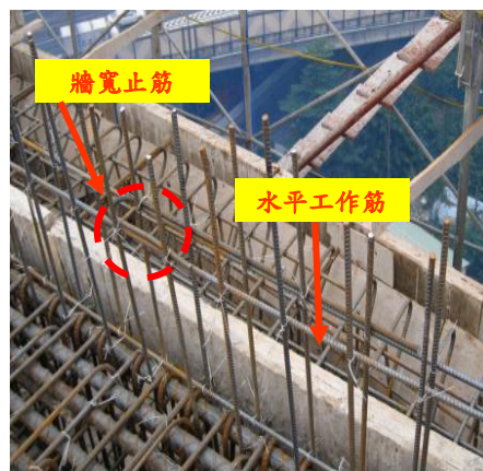
對：牆預留筋以水平工作筋固定，寬止筋確實綁紮。
