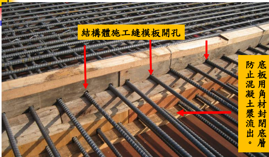
樓板鋼筋預留情形及模板開孔讓鋼筋貫通情形
