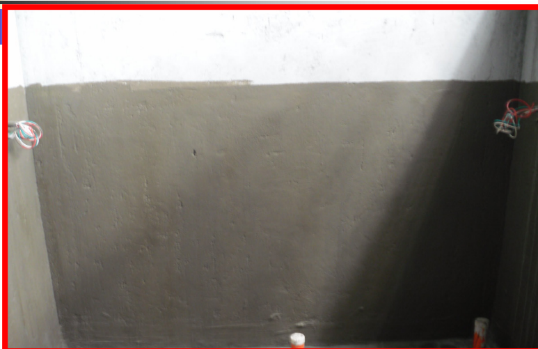
廁所防水施工高度 150-180cm
