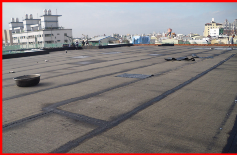
防水毯施工 疊接寬度10-15cm 接縫應交丁錯接
