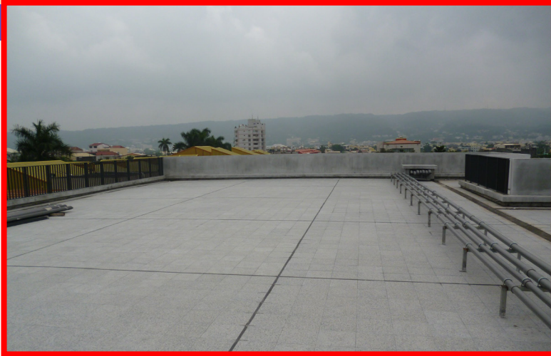
隔熱磚設置伸縮縫
