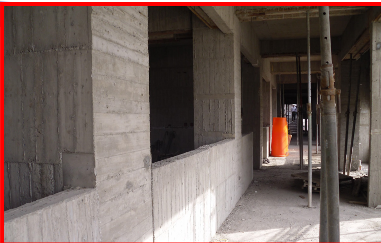
混凝土澆築良好
