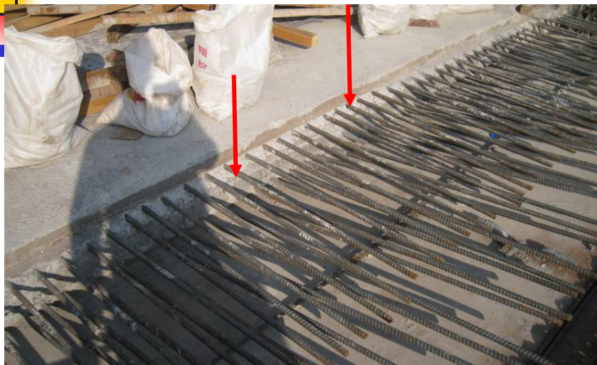
清理完成之結構體施工縫 - 楔型
